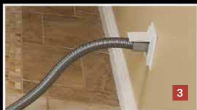
Les prises d'aspiration sont disposées à des endroits stratégiques.
